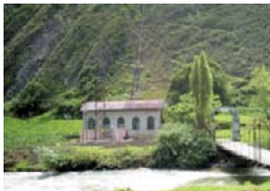
Central Hidroeléctrica sobre el río Hualgayoc, Cajamarca.
