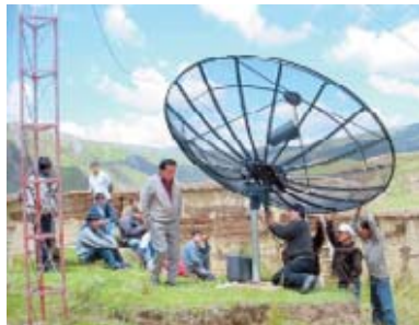
Instalación de la antena parabólica para la comunidad de Huaylacucho, provincia de Angaraes, departamento de Huancaavelica.
