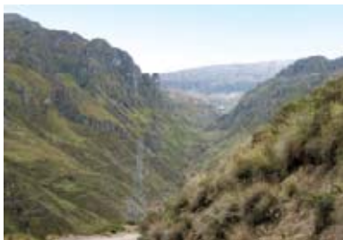
Tramo de línea de transmisión eléctrica Huancavelica-Castilla (Arequipa).
