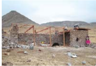
Construcción de cobertizo para proteger crías del frío.
